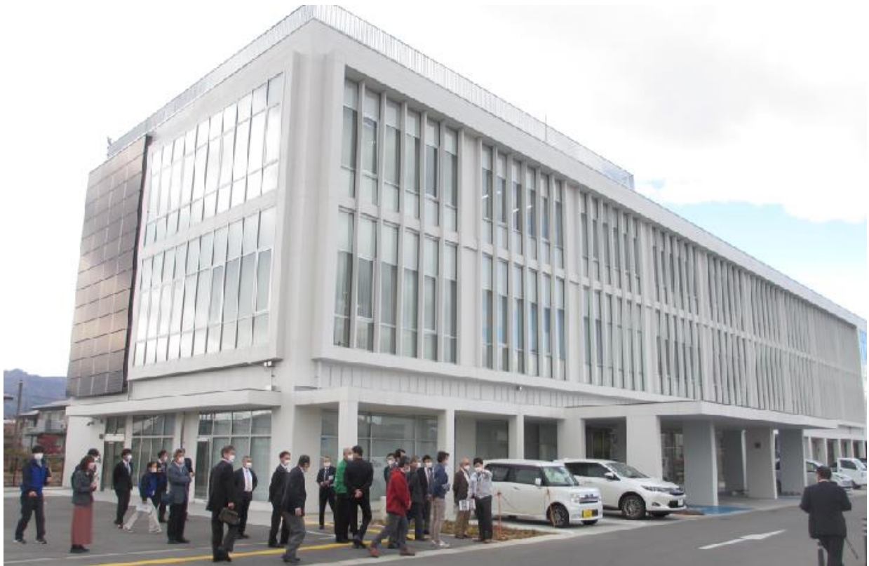
長井市役所本庁舎側です。自動車が駐車しているところは、無散水消雪スペースです。
